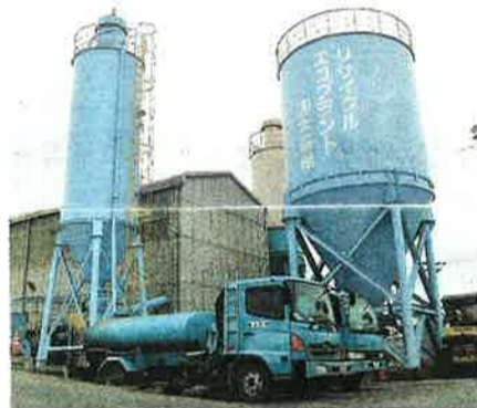
焼却灰の再利用を可能にし、全国から注目されている灰処理プラント施設
